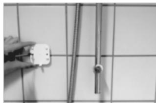
Installieren Sie die Halterung auf Augenhöhe in der Duschkabine.
