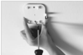
Installieren Sie die Halterung an der Decke in der Duschkabine.
